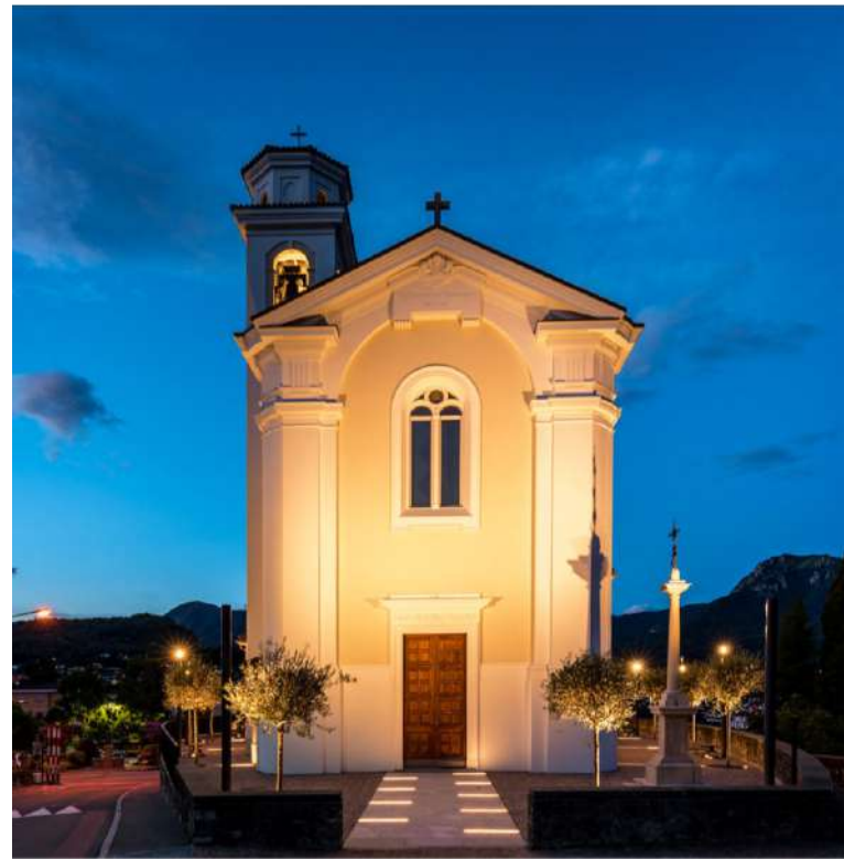
Rif. 1 - Illuminazione della facciata
